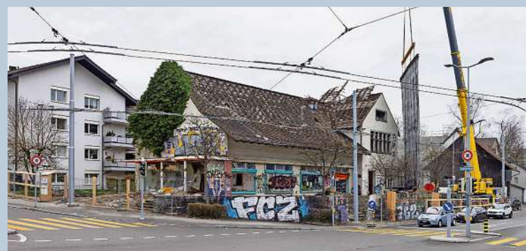
Ein Quartier im Umbruch: Abbrucharbeiten im Witiker Zentrum, 2024.
